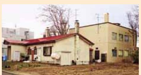
北側から撮影。建物左側の老朽部分が改築される
