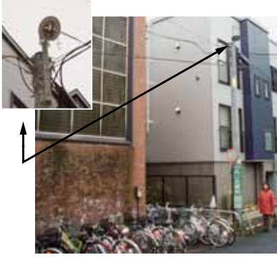
駐輪場に設置された街灯
