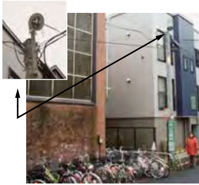
駐輪場に設置された街灯
