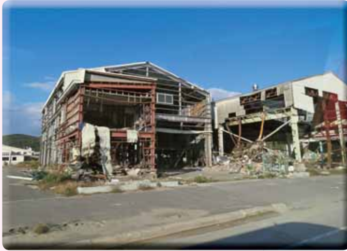
津波によって破壊された石巻市の工場
